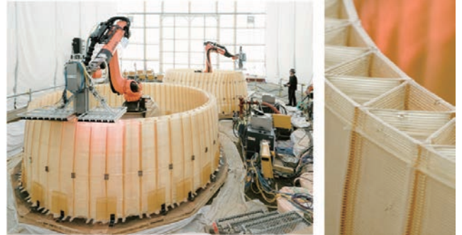
3Dプリンターによる施工状況
