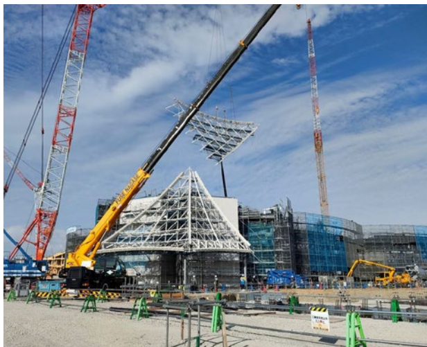
図9 大阪ヘルスケアパビリオンの建築工事進捗状況
