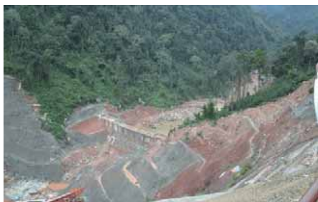
撮影位置付近に主ダムの堰堤が構築され、右側の部分は水没する
