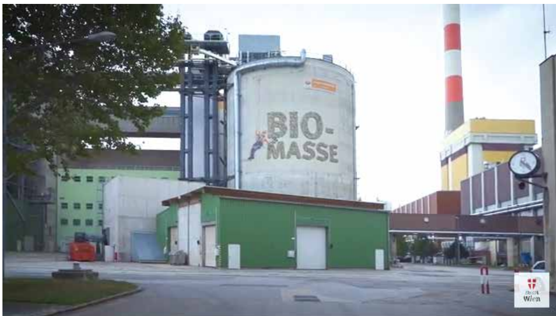
ジンメリング・バイオマス発電所 HPより
