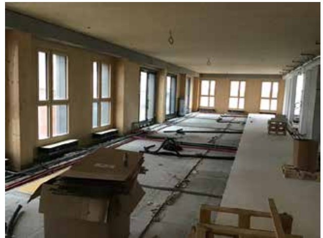
低層部の内部空間1 (床未施工)
