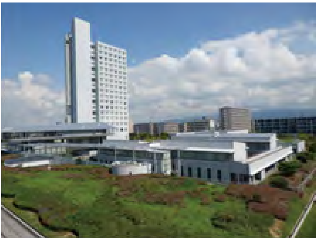
写真1 関西国際センターの全景
